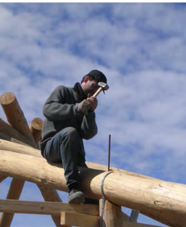
Bærende trækonstruktion af lokalt fældet rundtømmer
